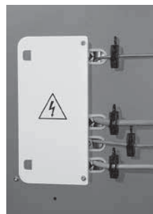
Remise en place plaque boîtier et serrage vis Torx
