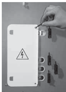
Desserrage 2 vis à l'aide d'une clef ou d'un tournevis Torx
